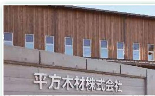
看板・木質外壁
